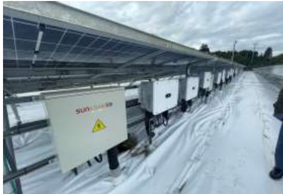
盗難防止対策 分散型パワコン導入 によりRS485制御線の煩雑さが増す状況
