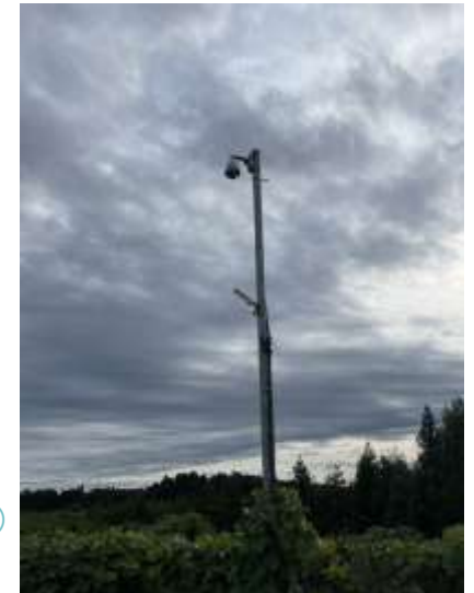
PV施設内電力送電ケーブル、PCS の盗難監視カメラ * POE/EtherブリッジNessum Wire 導入で低コスト化、工期短縮化
